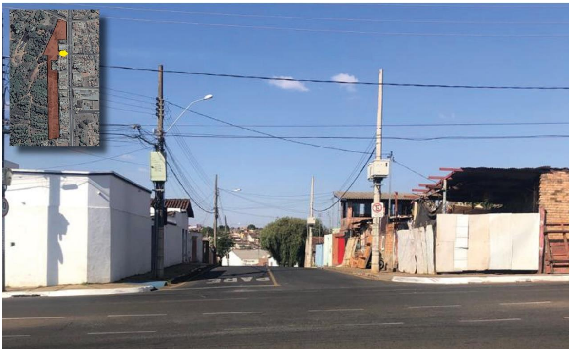
Figura 5: Vista da rua Valdemar de Siqueira, em frente ao futuro acesso de veículos.
