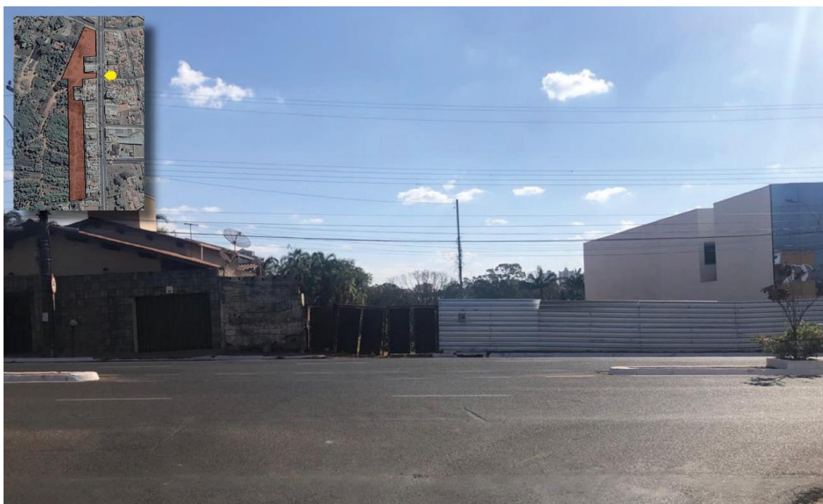
Figura 6: Vista parcial do terreno – Futuro acesso de veículos.
